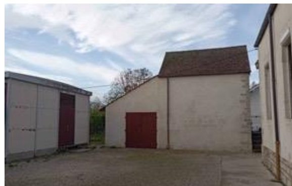
Bâtiment préfabriqué © CAUE 21
