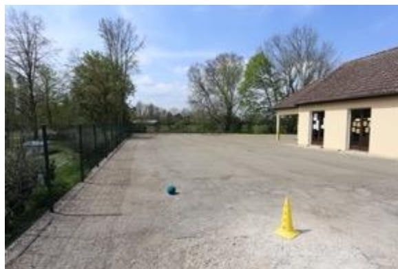
Cour très minérale et enrobé vieillissant
