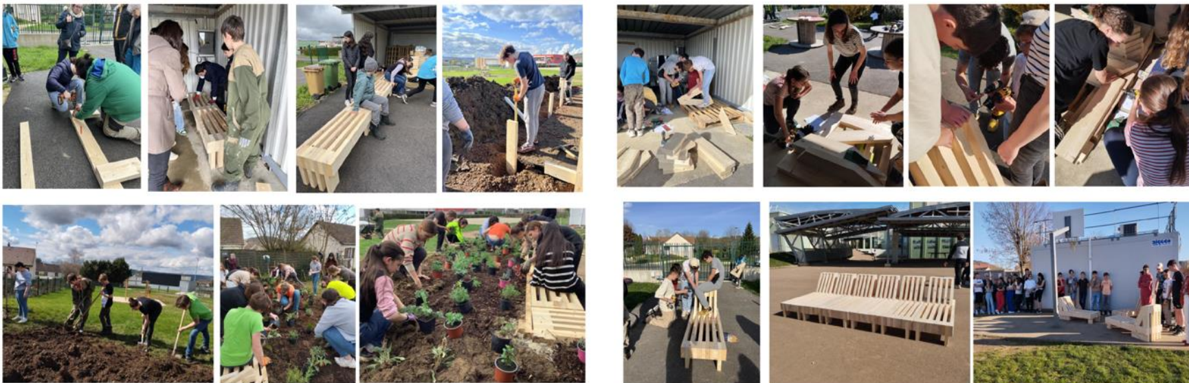
Les chantiers d'îlots plantés et méridiennes avec les élèves –
