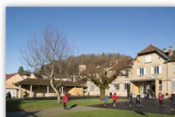
Groupe scolaire "Simone-Veil" - restructuration et extension, Montmorot (39)
