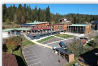
Centre de vacances "Le Duchet" - Rénovation Extension, Nanchez (39)
