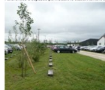
Parking en mélange terre-pierre du Gymnase de Longvic (21).
