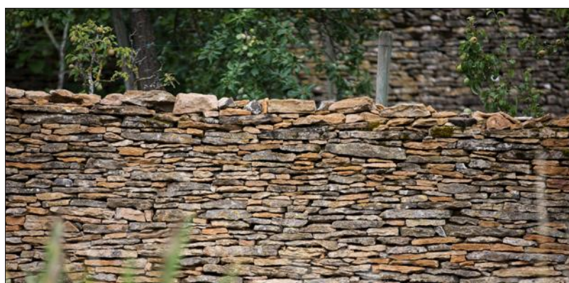
■ Pour constituer des murs et murets, les pierres sèches sont associées de manière astucieuse sans liant. Photo J. B.
