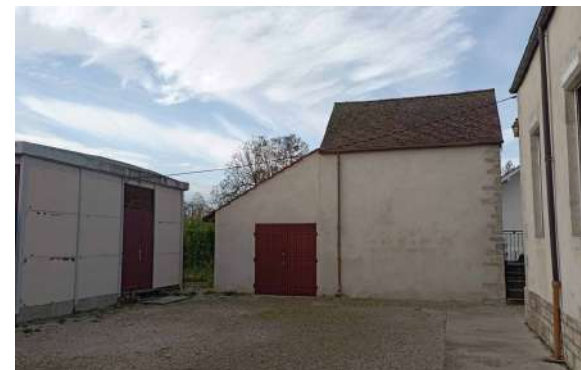
Bâtiment préfabriqué © CAUE 21
