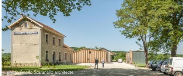
Les grandes façades des gîtes sont bardées de mélèze en plaques 3 plis de 60x80 cm, recouvertes de couvre-joints mélèze. Les entrées sont marquées par un auvent métallique et une dalle béton au sol.
